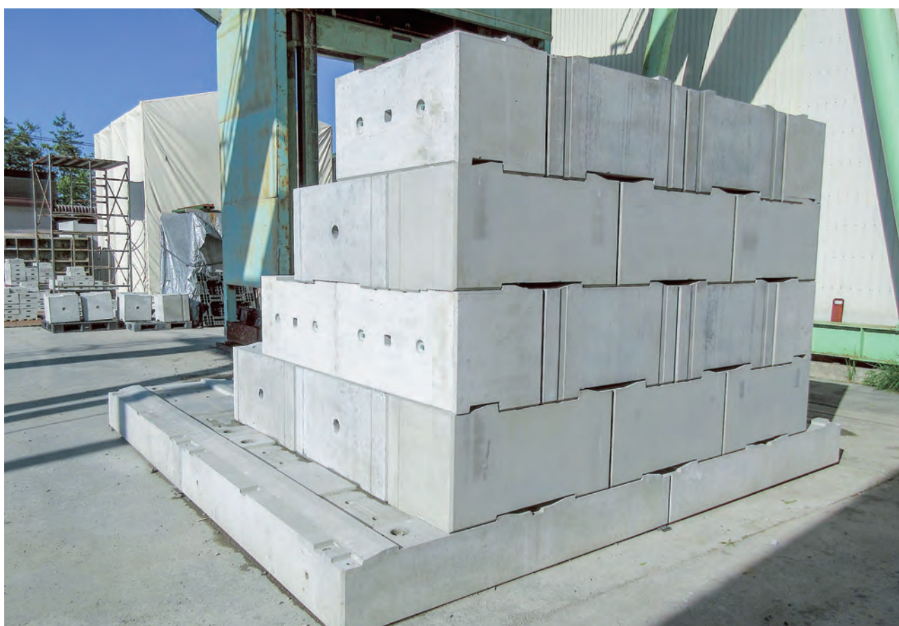
重力式擁壁 弊社工場内での仮設施工。施工後分解した後、再度組み立てをし、仮設後の再利用が可能であることを確認した。
