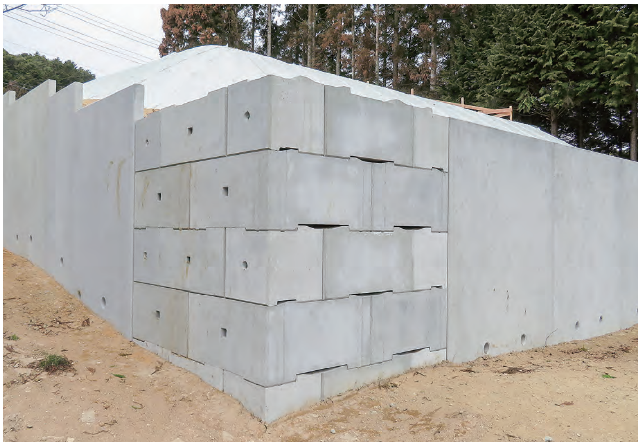
コーナー擁壁 ラフテレーンクレーンの進入できない現場であったため、バリアブロックをクレーン機能付きのバックホウで施工。
