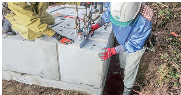
② 1段目のバリアブロックの据え付け
