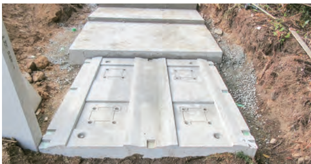
① 専用台座ブロックの据付
