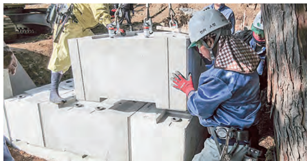
④ 2段目のバリアブロックの据え付け
