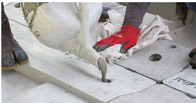
③ 無収縮モルタル施工状況
