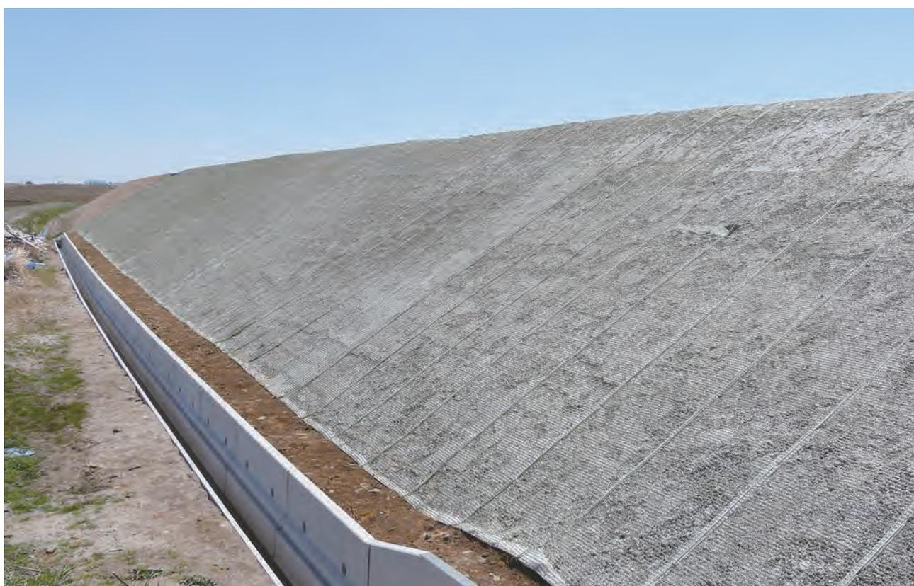
盛土断面に対応するプレキャスト側溝付擁壁
