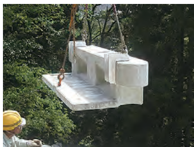
製品の吊り上げ
