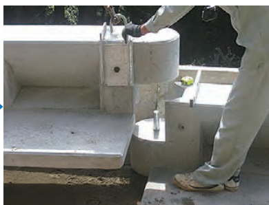
連結鋼の設置
