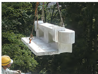
製品の吊り上げ
