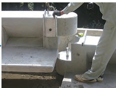
連結鋼の設置
