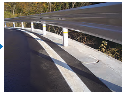
埋め戻し+舗装
