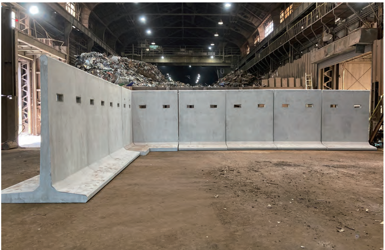
コーナー部材を活用した資源物リサイクル施設内の分別ヤード
