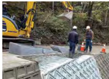
ブロック積の天端に
