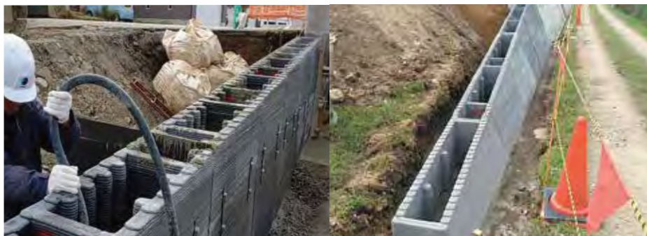
重力式擁壁の型枠に
