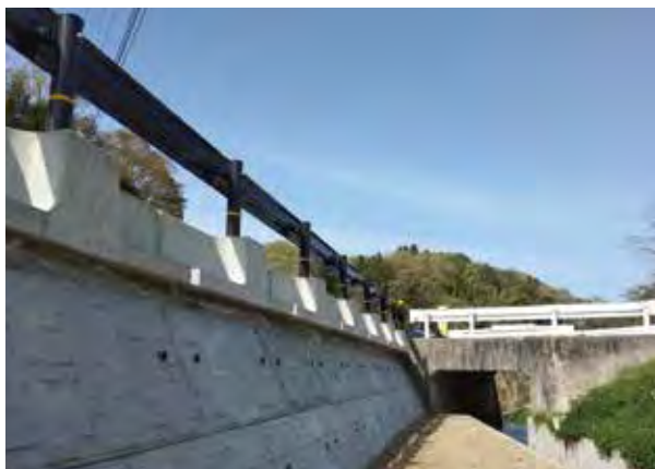
ブロック積み 擁壁上に設置
