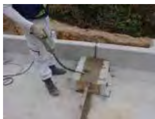
連結ボルト被覆部 コンクリート打設
