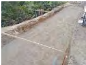
砕石基礎の施工
