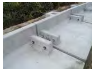
連結ボルト設置
