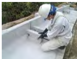
連結ボルトの設置状況
