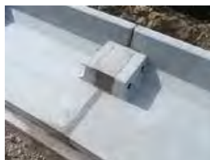
縦壁より背面の底版の 間詰めコンクリート完了
