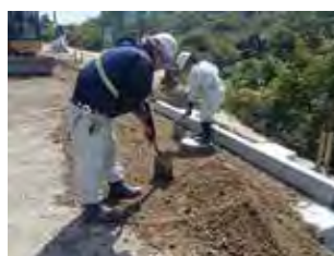
埋め戻し状況
