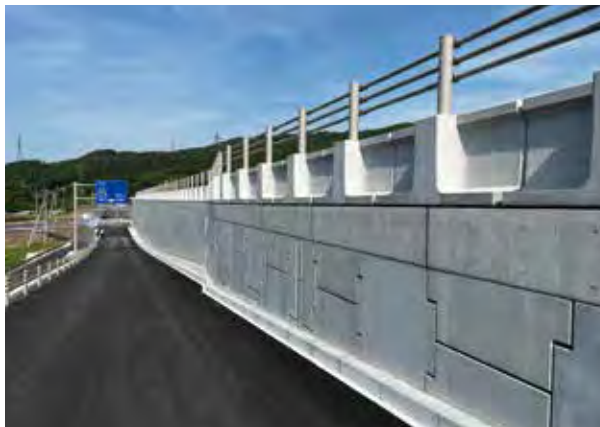
補強土壁上に 設置
