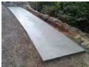
均しコンクリートの打設
