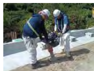
締め固め状況
