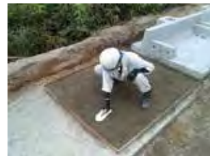
敷モルタルの施工
