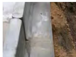
縦壁より前面の底版の 間詰めコンクリート完了
