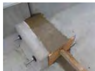
連結ボルト被覆部の 間詰めコンクリート完了
